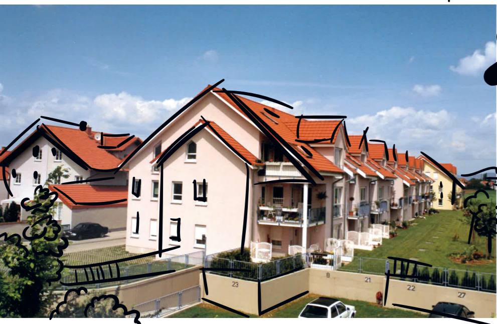
Eigenheime in Schwetzingen, erbaut 1993–1995
