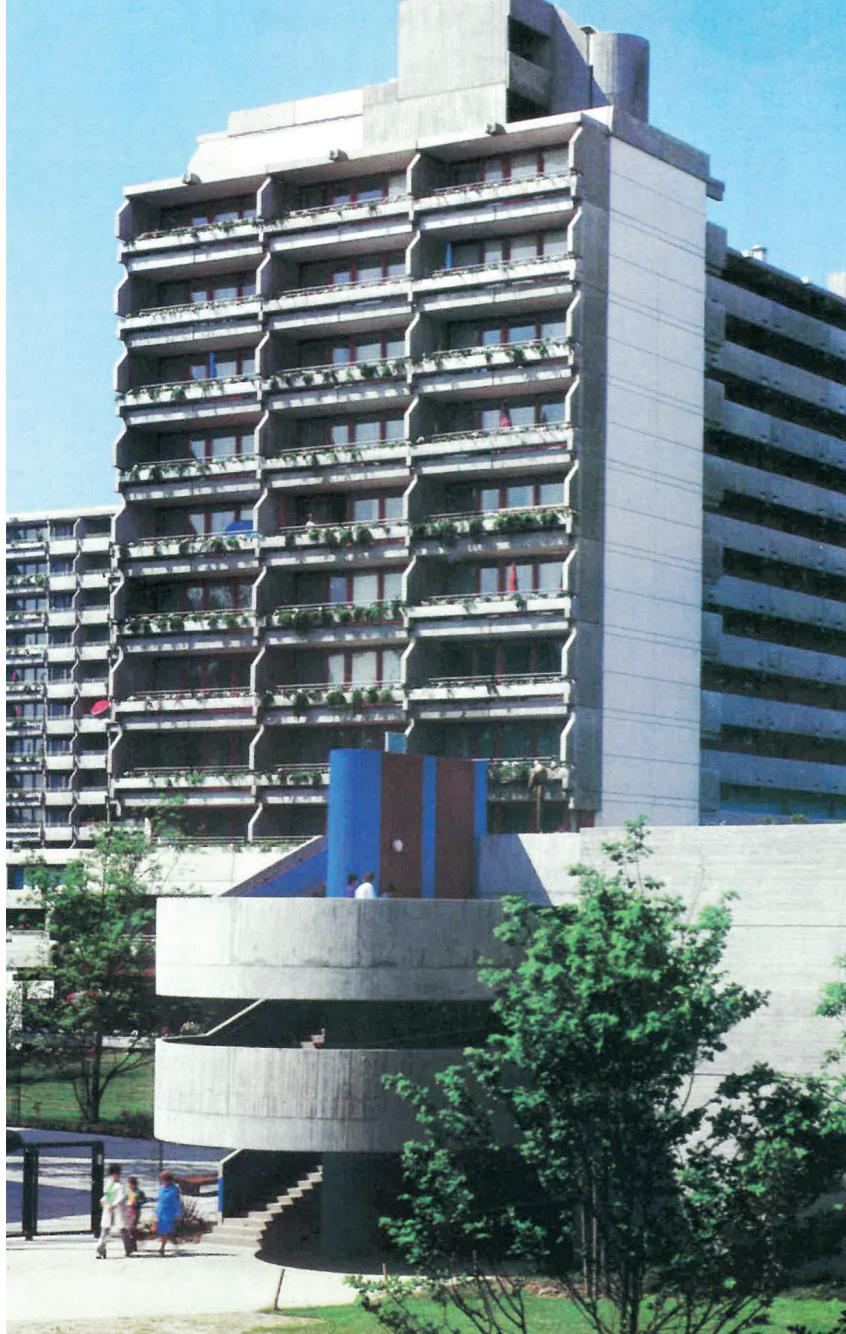
Mehrfamilienhäuser in Mannheim-Herzogenried, erbaut 1974/1975
